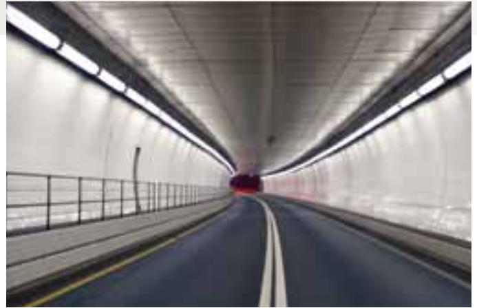
► Fort McHenry Tunnel (I-95)
