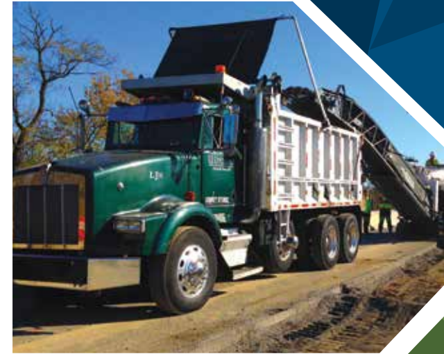
I-895 Patapsco Flats
