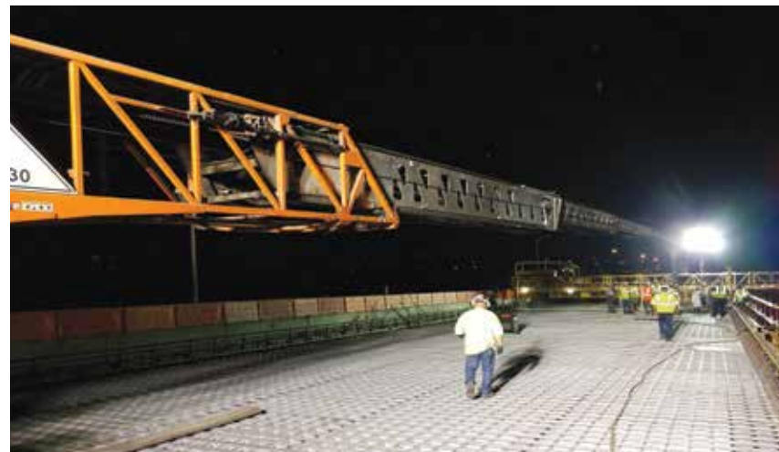
I-895 Patapsco Flats
